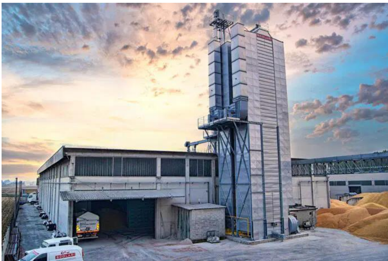
Рис. 2.1. Італійська шахтна зерносушарка Scolari.
