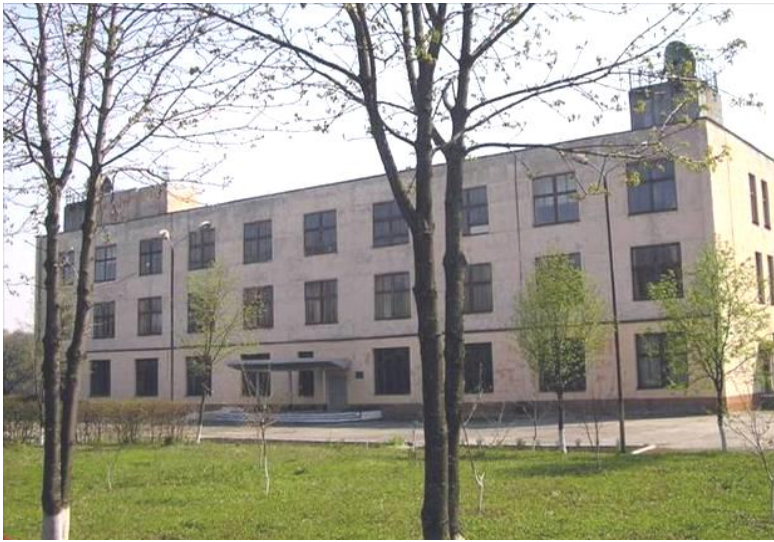
Загальний вигляд споруди НС СКТРЛ М1
