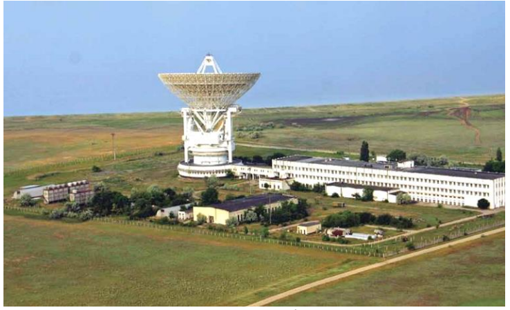
Загальний вигляд позиції РТК “Квант-Д”
