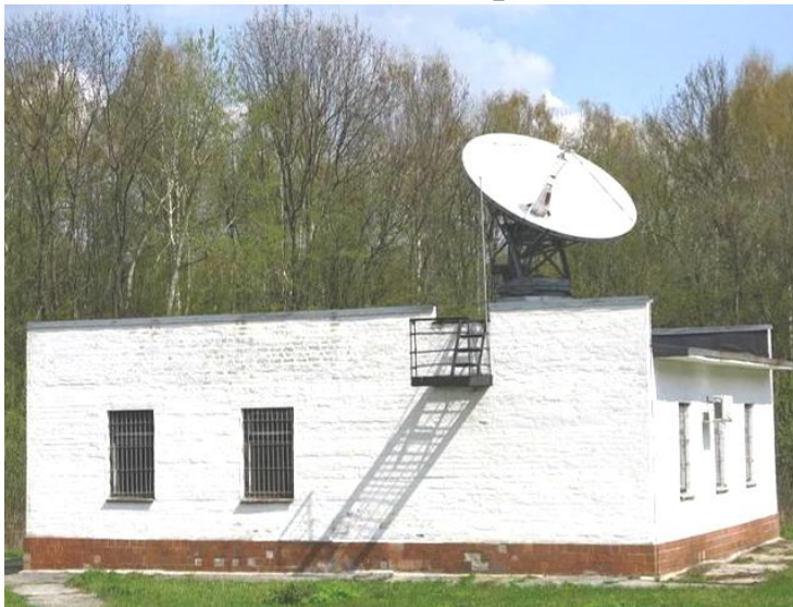
Загальний вигляд ПС-8,2
