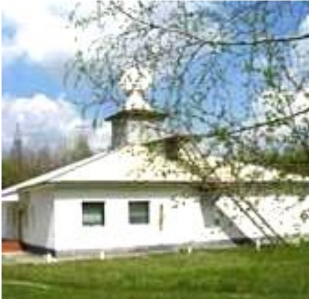
Загальний вигляд НПРС СІРЛ-МС
