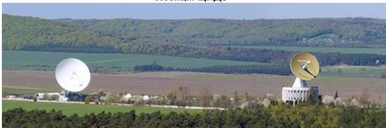
Загальний вигляд ЦКДЗ
