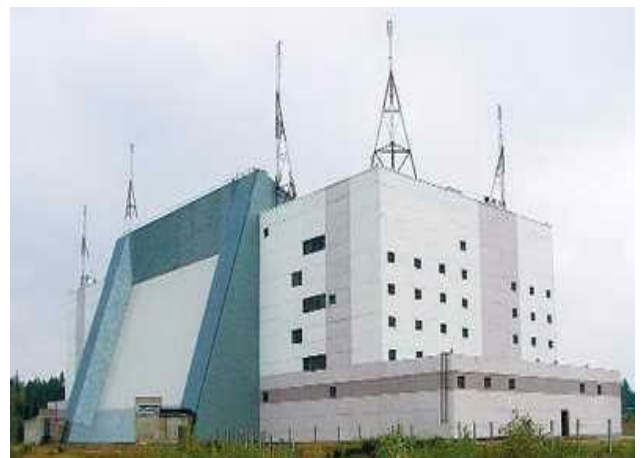
Загальний вигляд передавача РЛС
