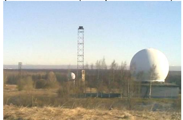
Загальний вигляд КВС "Тамань-База-ДМ"
