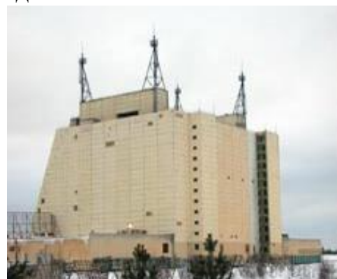
Загальний вигляд передавача РЛС
