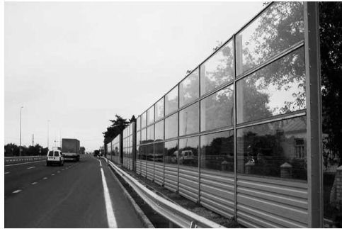
Рис. 2.9. Приклад встановлення шумозахисного екрану
