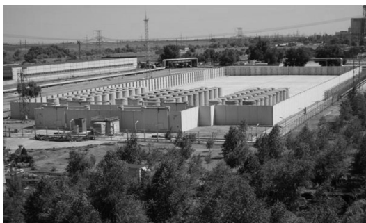
Рис. 4.5. Комплекс сухого сховища відпрацьованого ядерного палива на Запорізькій АЕС
