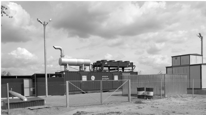
Рис. 4.12. Установка для уловлювання біогазу на полігоні ТПБВ (м. Житомир)
